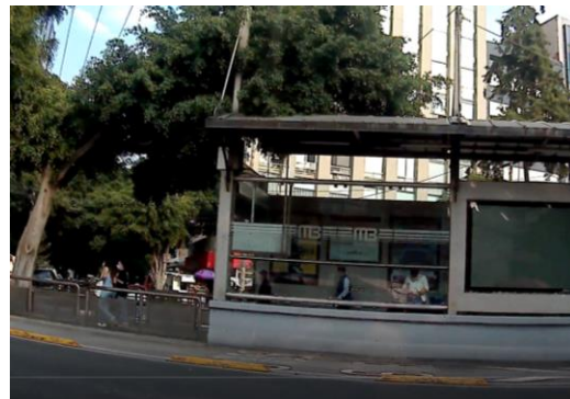
Equipamiento de transporte (Estación de METROBÚS)
