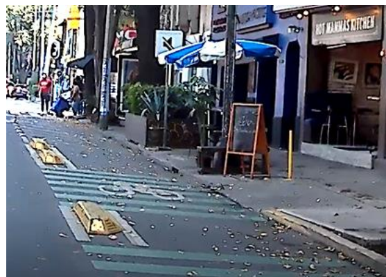
Ciclovía confinada sobre Av. Nuevo León
