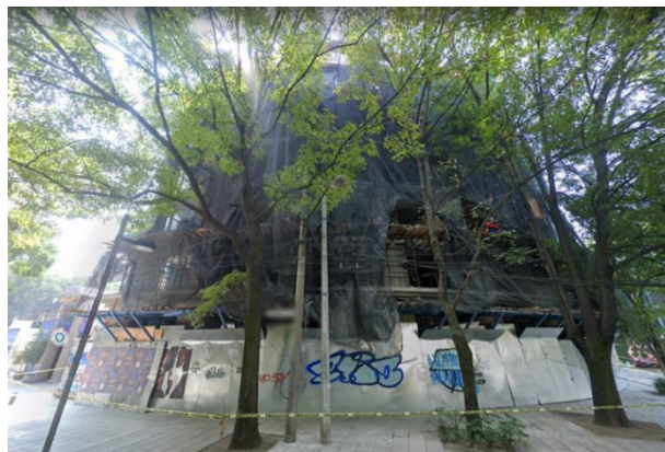
FRENTE DEL PREDIO VISTO DESDE AV. MÉXICO
