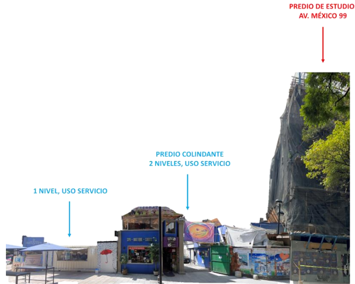
VISTA DESDE AV. MÉXICO
