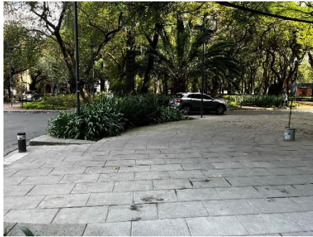
Banqueta frente al predio
