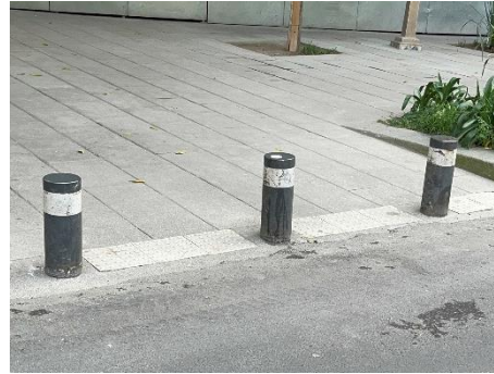
Rampa, bolardos y mosaicos podotactiles
