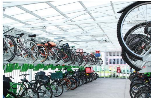
| Biciestacionamiento Semimasivo en Buenavista
