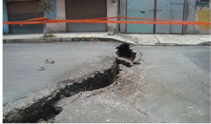
Sismo y fracturamiento. Izq. Calle Liborio Crespo dañada por activación de fracturamiento a causa del sismo de 2017. Der. Calle Circunvalación en Santa María Aztahuacán afectada por la activación de una fractura.
