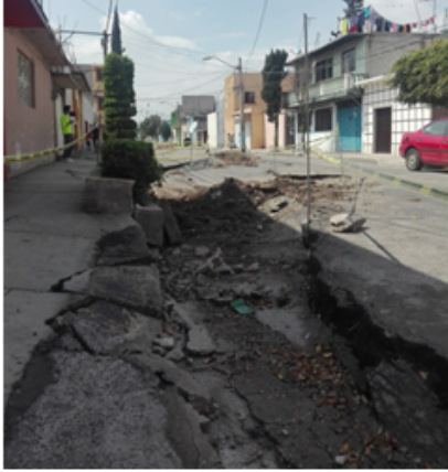
Sismo y fracturamiento. Izq. Calle Liborio Crespo dañada por activación de fracturamiento a causa del sismo de 2017. Der. Calle Circunvalación en Santa María Aztahuacán afectada por la activación de una fractura.
