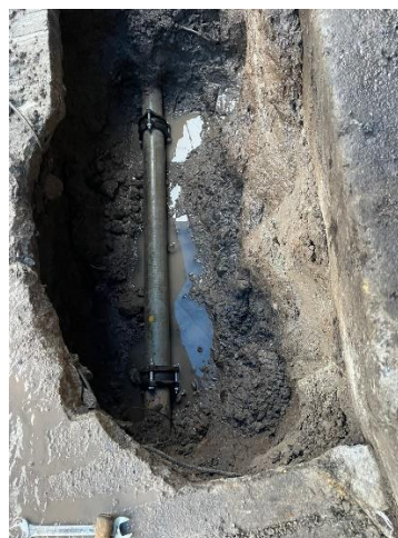
Reparaciones de rompimiento de tubo
