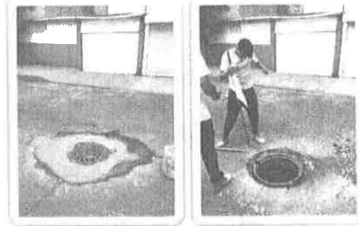
Reposición de brocal y tapa de vista de hierro fundido (tapa Sustraída), por brocal y tapa de polietileno.
